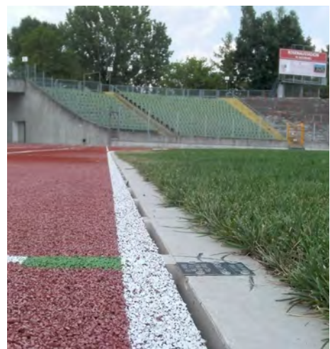
Schlitzrinne beidseitig beschichtbar
