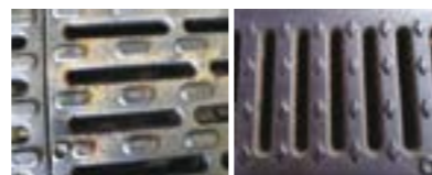
Slike prikazuju fazu procesa patinacije. Period oksidacije zavisi od uslova okoline. Na fotografiji sa desne strane se nalazi rešetka kako izgleda u zonama frekventnog saobraćaja.
