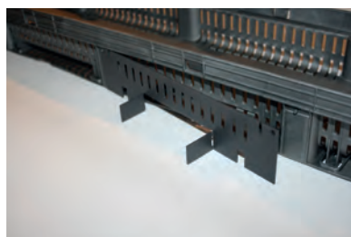
Postavljanje spojnog elementa na žabice.
