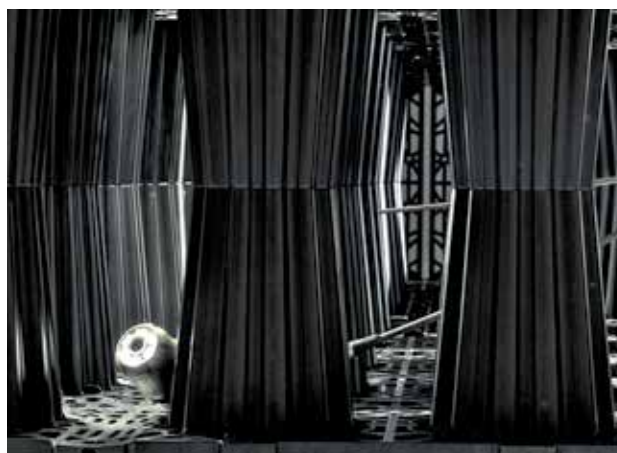
Kamera sa potisnim kablom (tzv. crv)
