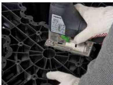
Izrada otvora na polublokovima za inspezione priključke
