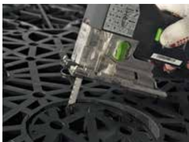
Izrezivanje otvora u bočnom panelu
