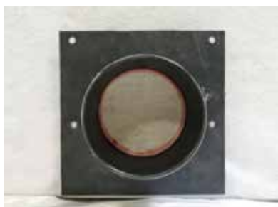
Izrada otvora u geotekstilu i montaža cevnog priključka
